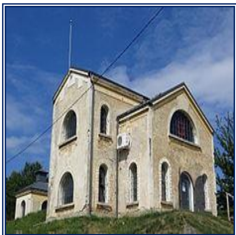
Fosta Uzină de Apă din Suceava
