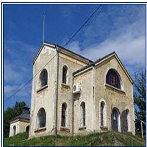
Fosta Uzină de Apă din Suceava
